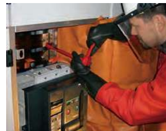
現場低壓電盤維護狀況
